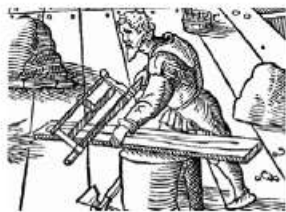
Ein Zimmermann bei der Arbeit mit einer Säge. (Feldhaus 1922)
